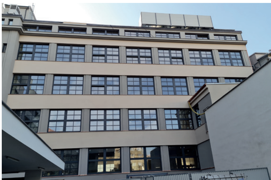
24. 9. 2020 Dvorní fasáda s klimatizacemi
