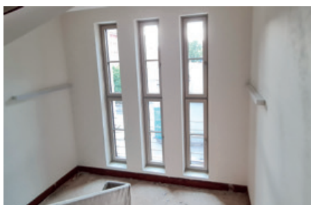
17. 9. 2020 Okna na schodišti.
