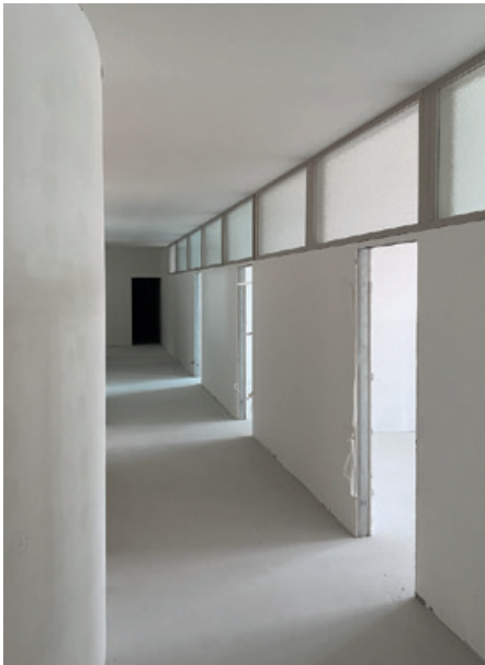
Nadsvětlíky v chodbě 7. 8. 2020
