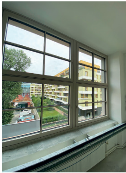
Nová okna v kanceláři 2. 7. 2020
